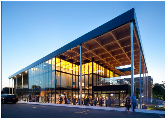
Figure 2.5 La salle multifonctionnelle de Mont-Laurier Site internet de Mont-Laurier
