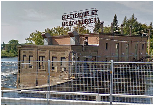
Figure 2.3 Centrale électrique Mont-Laurier Google Street
